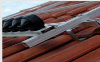
**12. Montieren Sie anschließend die Fußleiste.**
