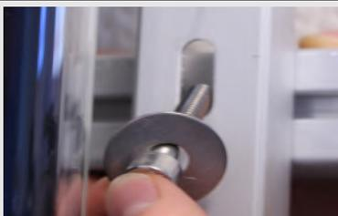
**9. Legen Sie den Kollektorrahmen an die Nutsteine an und befestigen Sie diese an den vorhandenen Langlöchern mit den Inbusschrauben und Unterlegscheiben (Teil des Verschraubungskits).**
